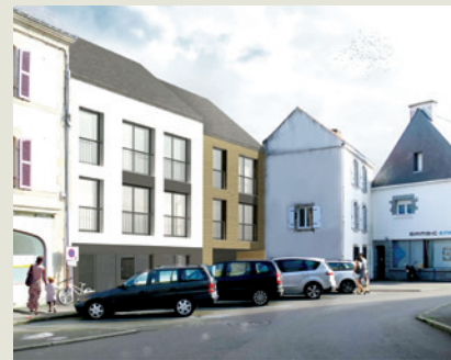
▲ Rue Leuriou (Finistère Habitat), création de 24 logements : 298 500 €
