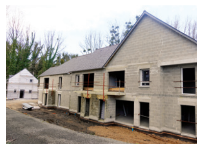
Rue du Faouët, 10 appartements et 2 logements individuels sont en cours de construction.
