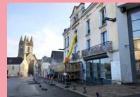
CULTURE LE CHANTIER DE LA FUTURE LUDOMÉDIATHÈQUE A COMMENCÉ
