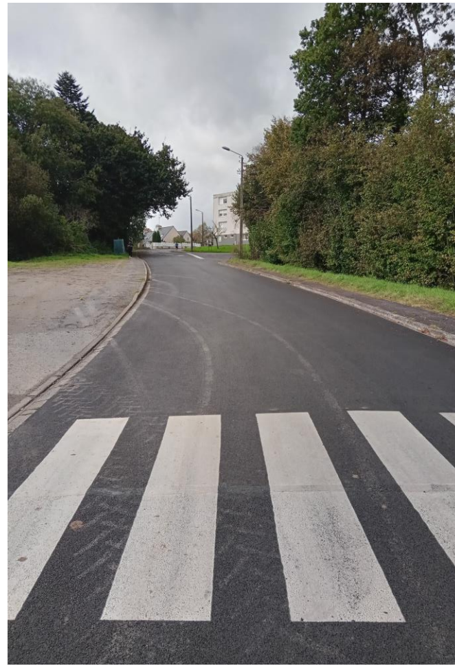
Rue de Kersquine : Reprise du revêtement
