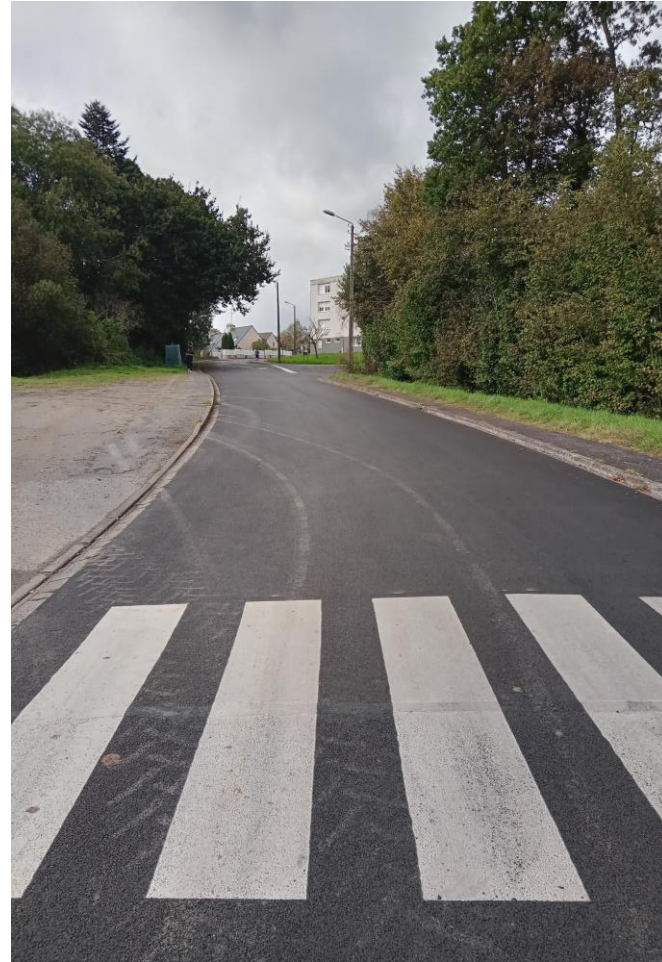
Rue de Kersquine : Reprise du revêtement
