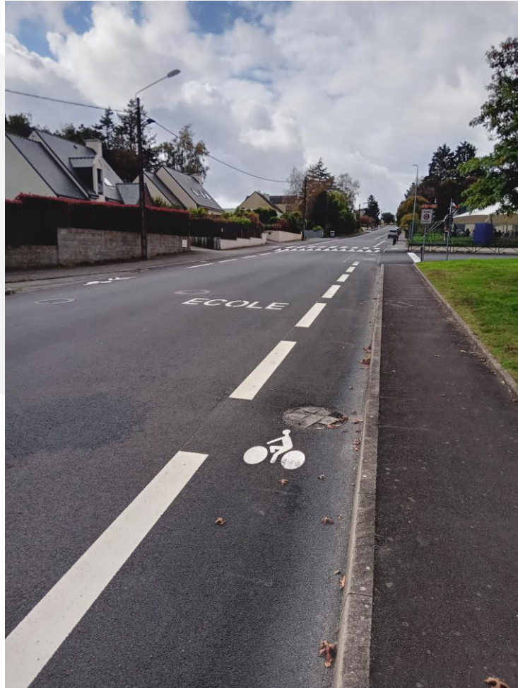
Rue de Kerjouanneau: Reprise du revêtement
