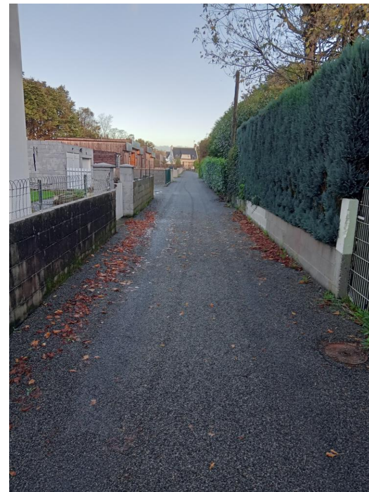
Rue du Coat Déro: Reprise du revêtement
