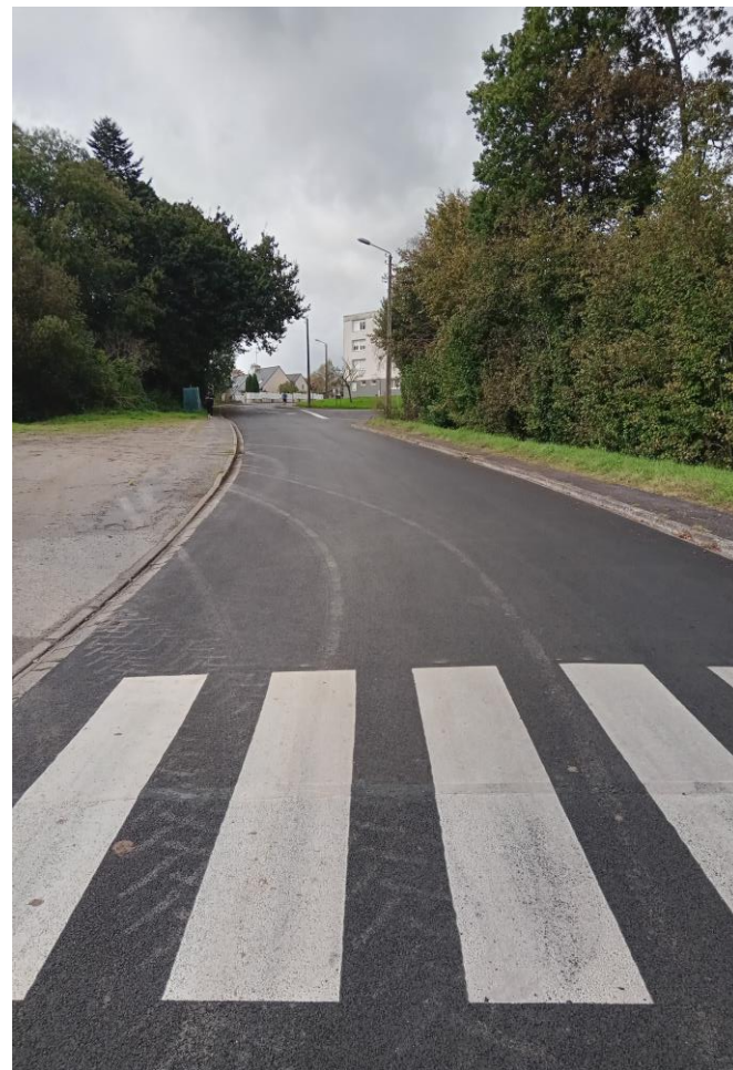
Rue de Kersquine : Reprise du revêtement
